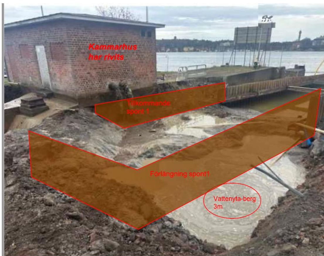
Figur 5 Tillkommande spont 1 för att stoppa inträngande sjövattnen
